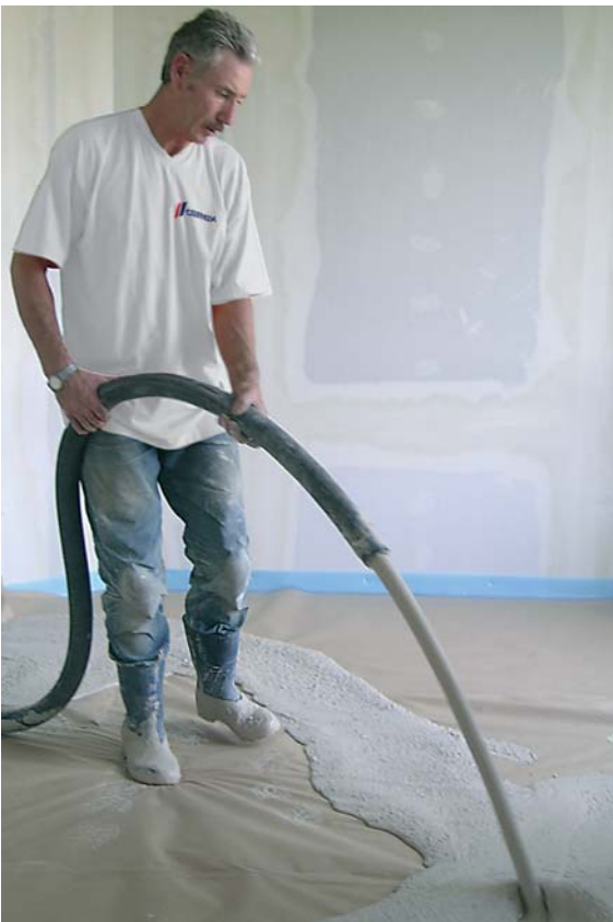
Der Fließestrich gelangt einbaufertig im Fahrmischer auf die Baustelle und ist dort sofort pump- und verarbeitbar
