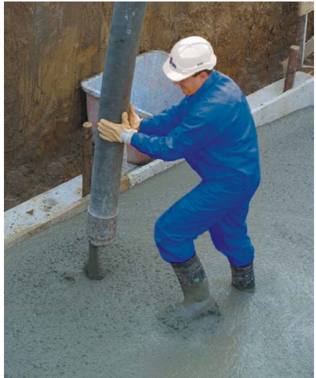
Die Verarbeitung von faton®: einfach per Pumpe oder mithilfe von Kran und Kübel oder Fahrmischerschurre
