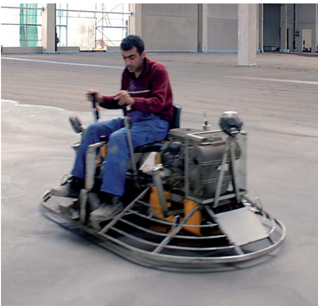
Das Glätten von faton® und das Aufbringen einer Verschleißschicht sind problemlos möglich
